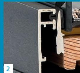
2 Hinterlüftete Leichtmetall-Deck- schale auf Flügel und Rahmen sind in nahezu unbegrenzter Farbvielfalt erhältlich
